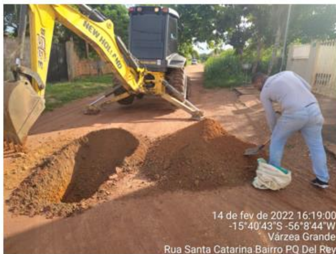
Coleta dos furos de sondagem
